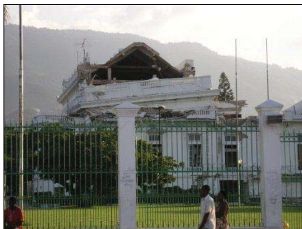
Il palazzo del governo distrutto dal terremoto
